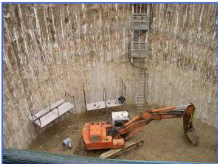
Esempio di parete realizzata con pali secanti CSP
